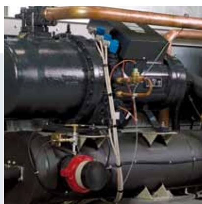
Flussostato e connessioni flangiate all'evaporatore, opzionali
